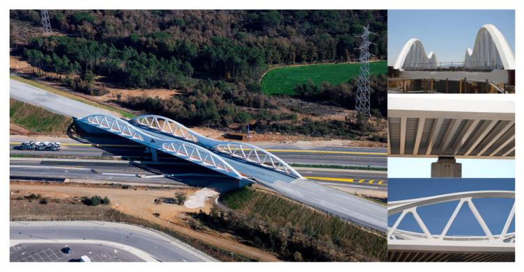
La estructura consta de un único tablero de 2 vanos, con luces 53.00 + 53.00 entre ejes, que dan lugar a una longitud total de 106.0 m. La estructura está muy esviada, de modo que los ejes de apoyos de pilas y estribos forman un ángulo de 34.3° con el eje de trazado de la LAV. La anchura del tablero es constante e igual a 15.70 m.
